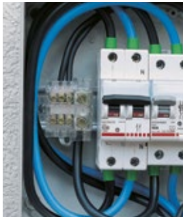
Z16-8D et Z6-6D montés sur des rails DIN. Utilisés dans les panneaux de contrôle
